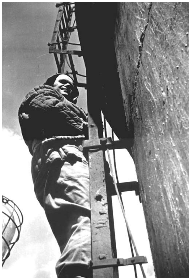
Фото 3. Организация контроля качества (мониторинга) на высоте при строительстве Останкинской башни – Борис Тринкер проверяет бетон оболочки башни с наружной временной лестницы, 1963 г.
