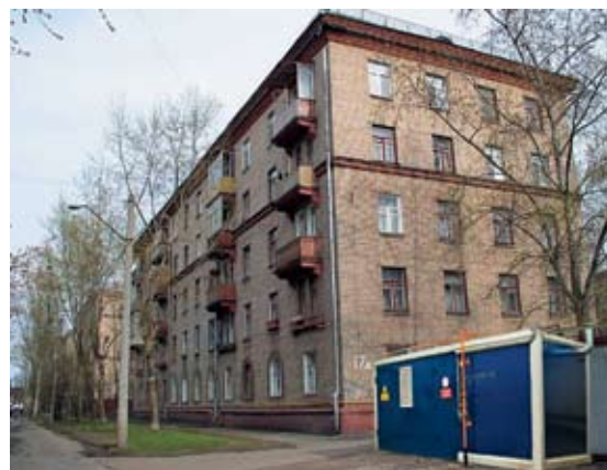
Рис. 2. Блочно-модульная котельная ИНТЕРБЛОК серии ST для отопления и горячего водоснабжения жилых зданий
