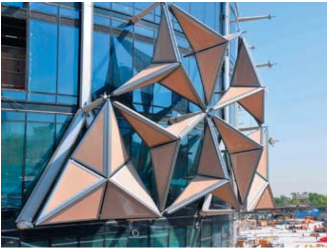
Фото 2. Al Bahar Towers, фрагмент башни
