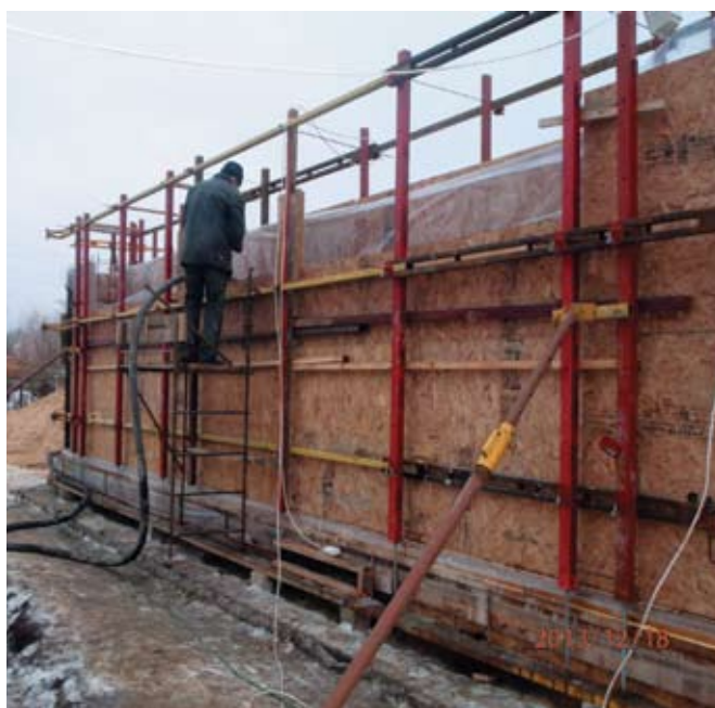
Фото 2. Заливка несущих стен поробетоном D=900 \text{ кг/м}^3
