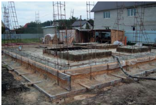
Фото 1. Бурозаливной монолитный фундамент с армодиском и отмосткой
